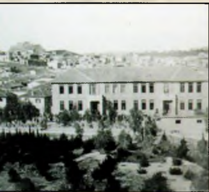
Δημοτικό Σχολείο Αγ. Τριάδας
